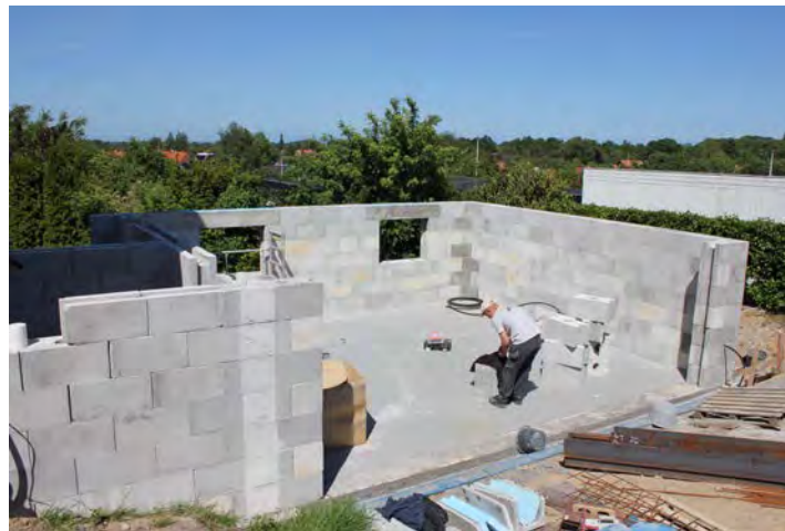
Tilbygning og garage i Hørsholm. Det bruges Smartbloc System I og SmartFloor
