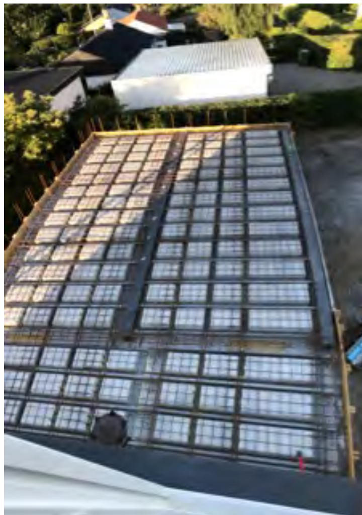
Tilbygning og garage i Hørsholm. Det bruges Smartbloc System I og SmartFloor
