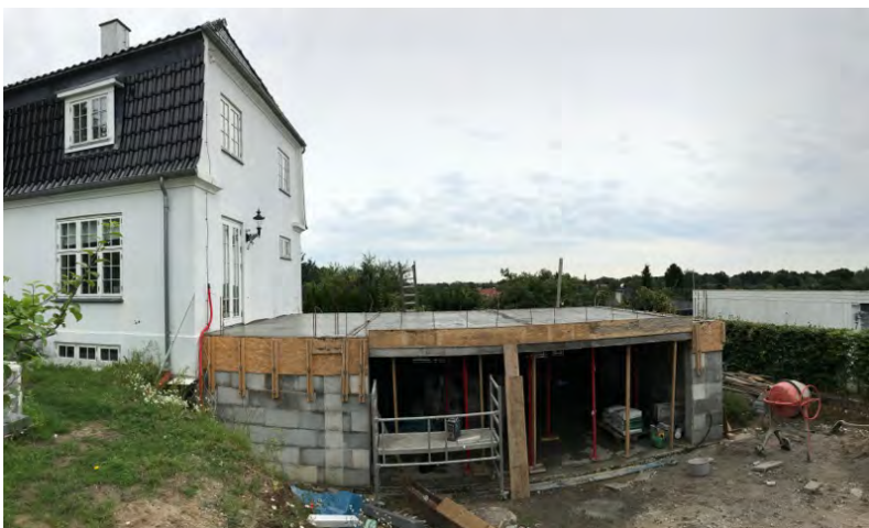
Tilbygning og garage i Hørsholm. Det bruges Smartbloc System I og SmartFloor
