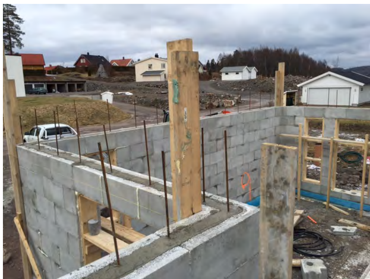
Andebu - færdigstablet, søjler CC 600 og U-blokke fyldt med B30 beton
