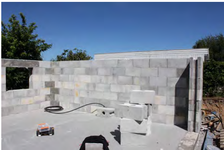
Tilbygning og garage i Hørsholm. Det bruges Smartbloc System I og SmartFloor
