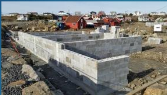
Første skift lagt ut og avrettet, armering og låseplugger monteres
