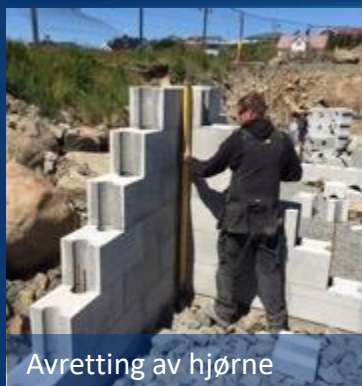
Første skift lagt ut og avrettet, armering og låseplugger monteres
